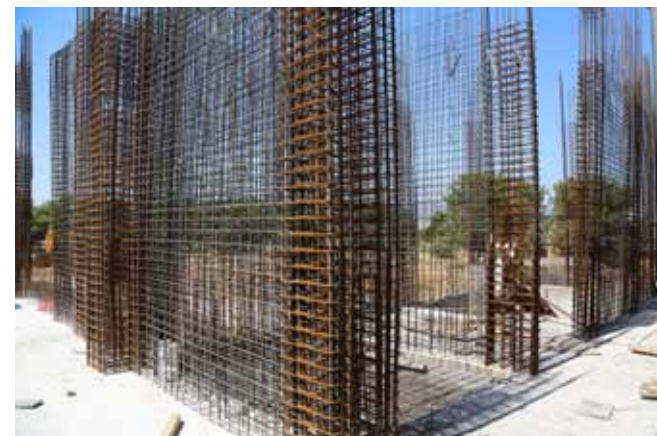
Стены между колоннами могут армироваться или прутками или сеткой
