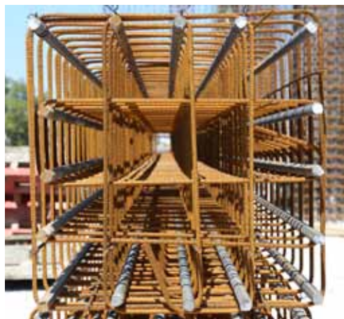
Поперечное сечение колонны с установленными несущими стержнями
