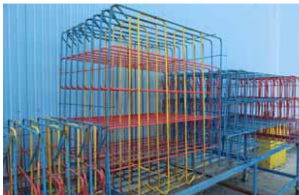
Образцы объемных каркасов для фундамента. Три составные части каркаса окрашены в разные цвета
