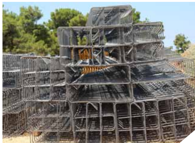
Пакет объемных каркасов состоит из каркасов различной конфигурации
