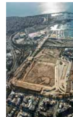
Вид строительной площадки с высоты птичьего полета
