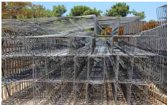
Пакеты объемных каркасов состоят из изделий различной конфигурации
