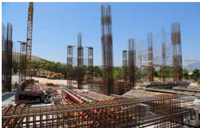
Армокаркасы колонн
